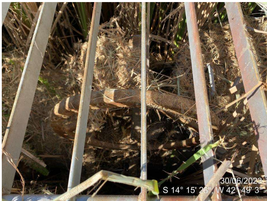
Figura 9 – Caixa de registros com excesso de vegetação.
