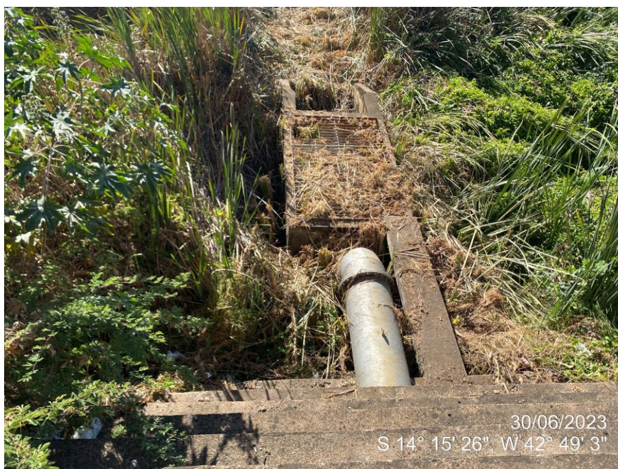
Figura 8 – Vista da tubulação de saída e caixa de registros.
