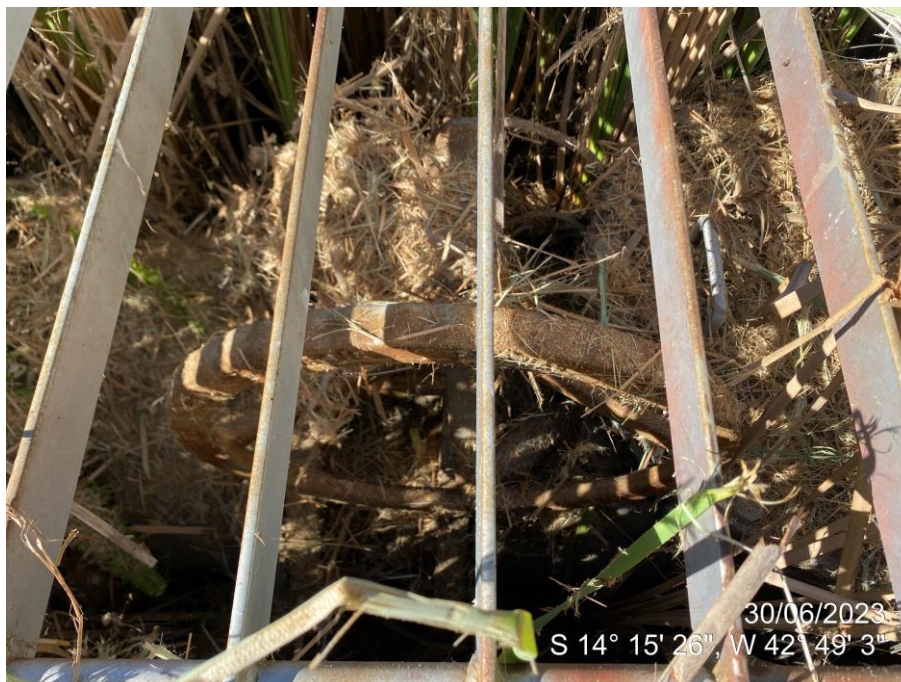
Figura 9 – Caixa de registros com excesso de vegetação.
