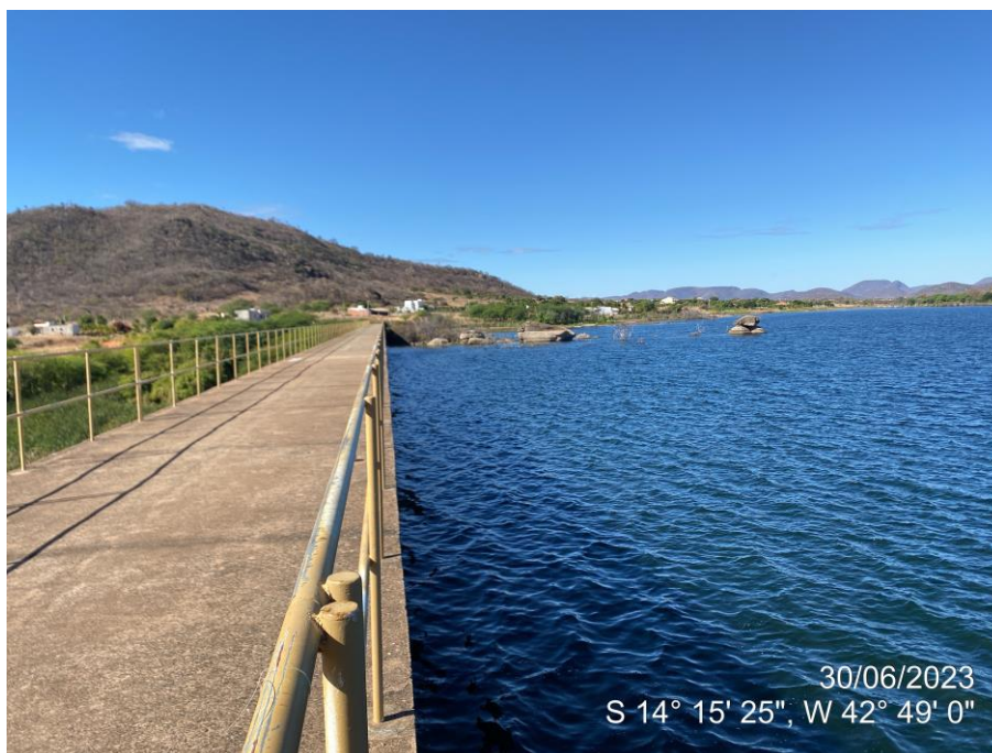
Figura 7 – Paramento de montante sem a presença de dispositivo de acionamento de comporta.
