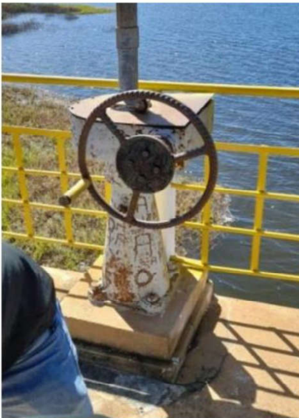
Figura 6 – Pedestal e volante de acionamento com sinais de oxidação.
