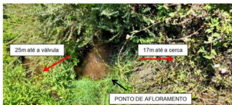
Figura 10 – Ponto com vazamento da tubulação. (Coordenada UTM 23 L0735991, 8359930)
