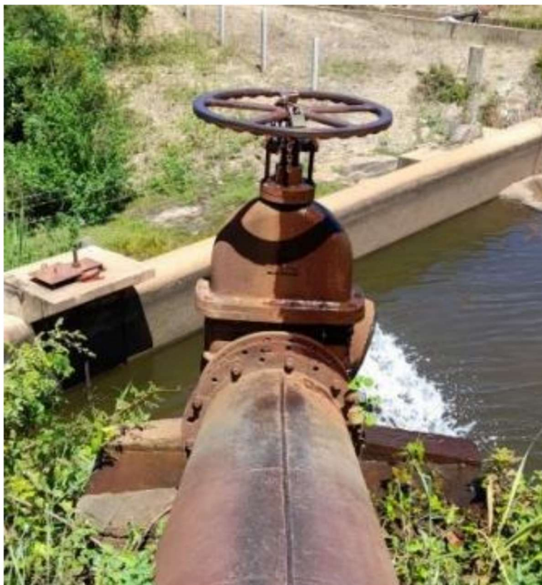
Figura 11 – Válvula de descarga de fundo (DN 500mm, PN10) inoperante em processo de oxidação.
