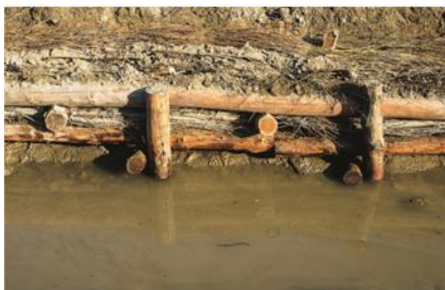
Figura 14 Muro simples de prumo frontal: exempli de aplicação e esquema conceitual. Fonte: Florineth 2004
