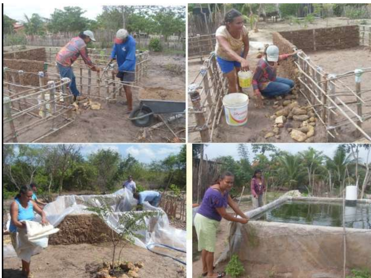
Figura 1 – Família construindo tanques para criação de peixes. Uso de taipa, varas e garrafa PET no Assentamento Cajueiro – Parnaíba – PI.
