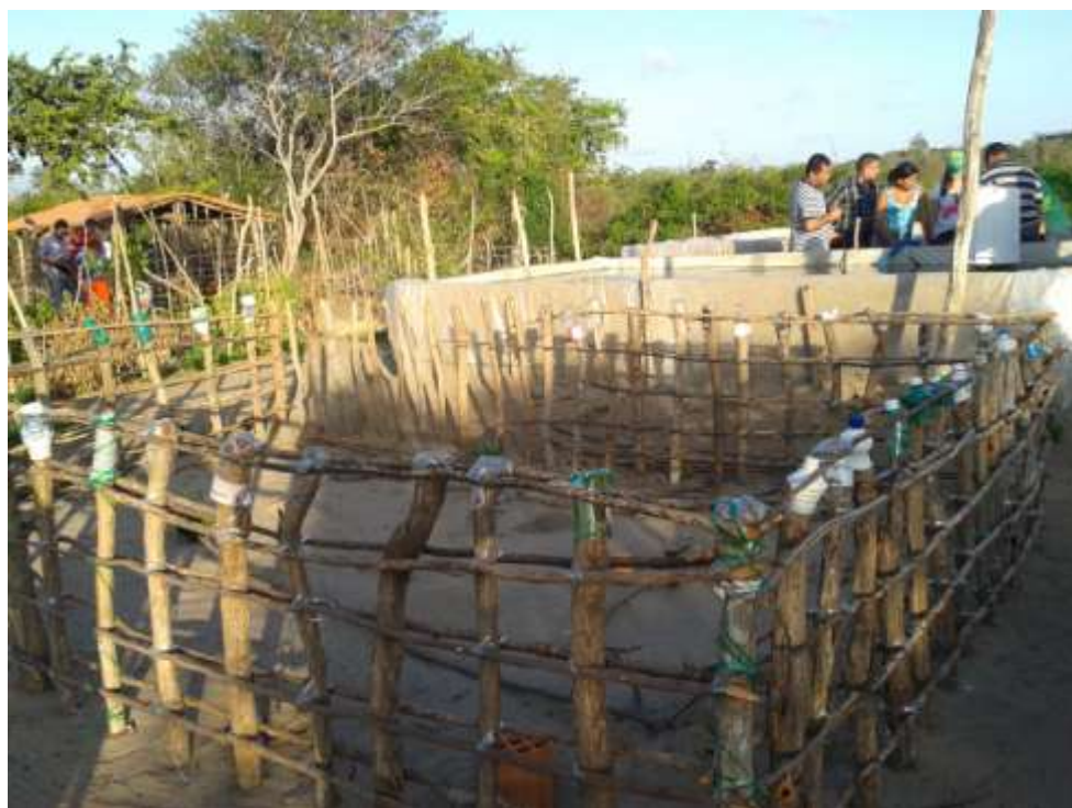
Figura 6 – Estrutura de 1 tanque aproveitando tiras e fundos de garrafas PET por família do Assentamento Cajueiro – Parnaíba – PI
