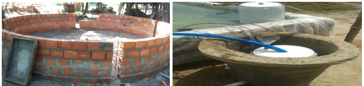
Figura 2 – Tanque de tijolo e cimento
