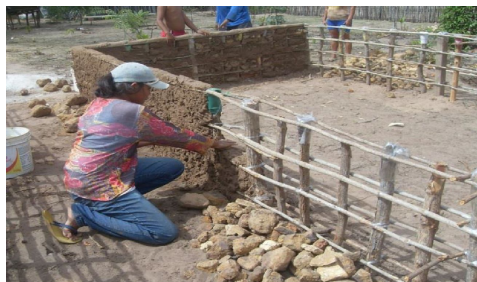
Figura 3 – Tanque de barro
