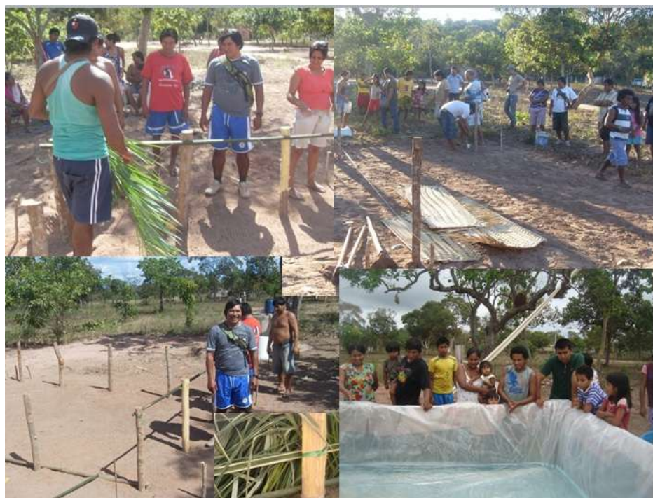
Figura 3 – Técnico indígena da etnia Gavião, treinado na Embrapa Meio-Norte em Parnaíba – PI, ensinando a técnica de construção dos tanques, com recursos naturais vegetais, para representantes de outras comunidades, na língua nativa Jê.
