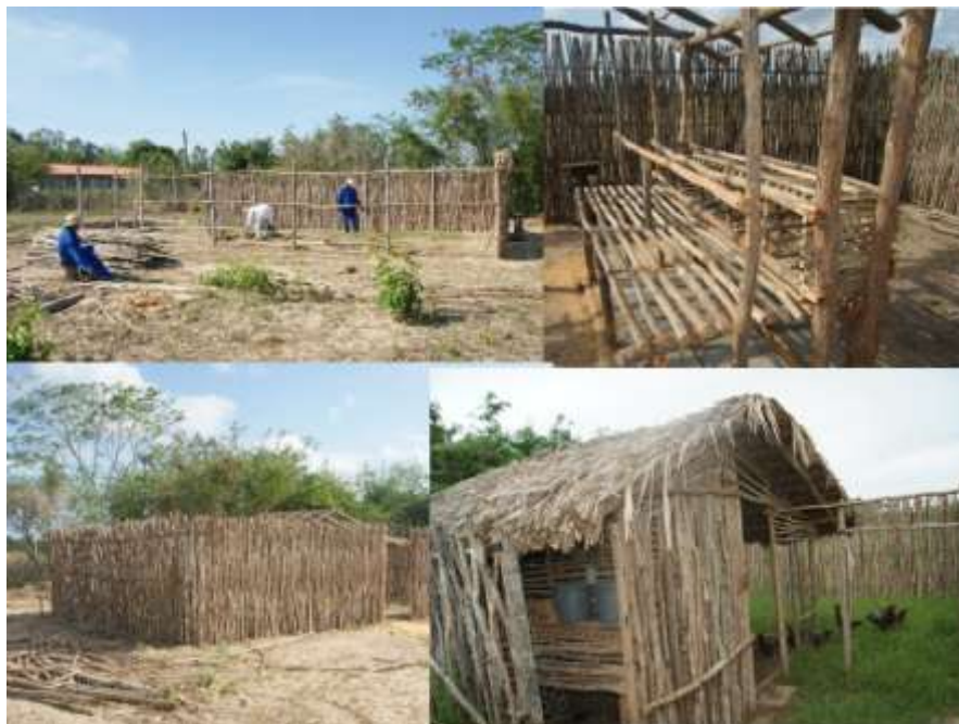
Figura 4 – Galinheiro construído na Embrapa Meio-Norte em Parnaíba – PI com materiais disponíveis no campo e o conhecimento compartilhado entre técnicos e funcionários.
