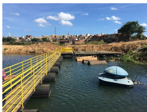
Sistemas flutuantes lado a lado
