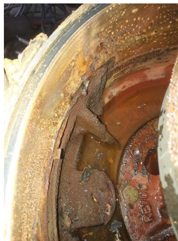
Corpo da eletrobomba anfíbia corroída
