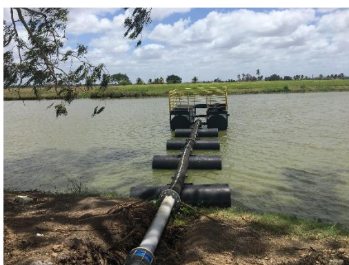
Flutuante em aço dentro d'água
