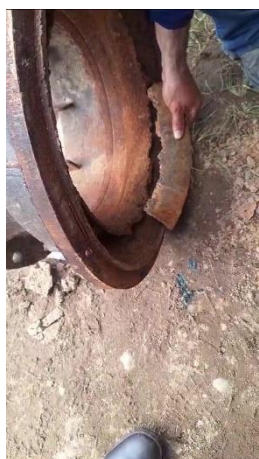
Anel de desgaste corroído
