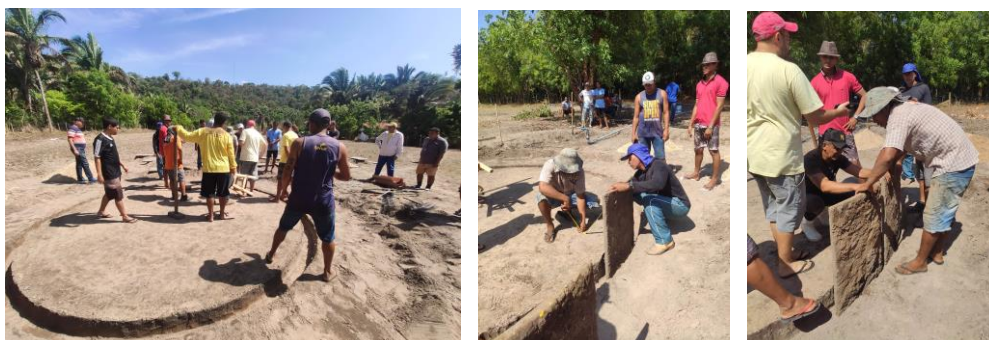
Figura 2: Ajuste no perímetro e encaixe das placas
