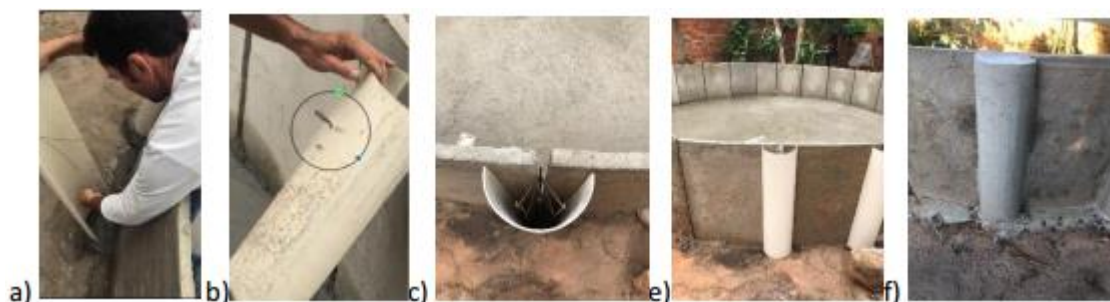
Figura 5: Demonstração da forma de PVC (200 mm) para a união das placas.
