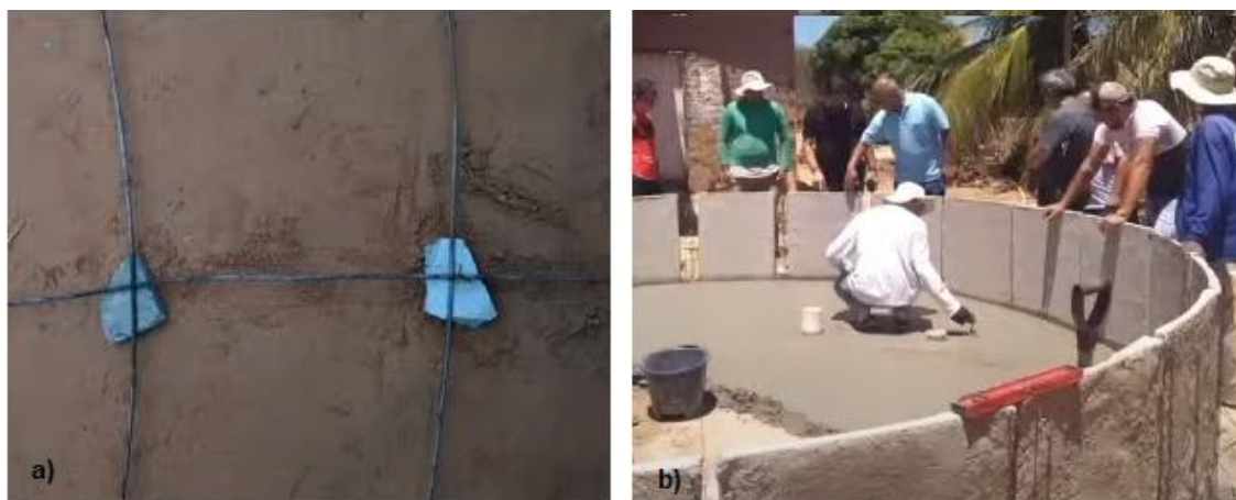
Figura 4: Detalhe da colocação dos calços de 2 cm e concretagem do fundo do reservatório.
