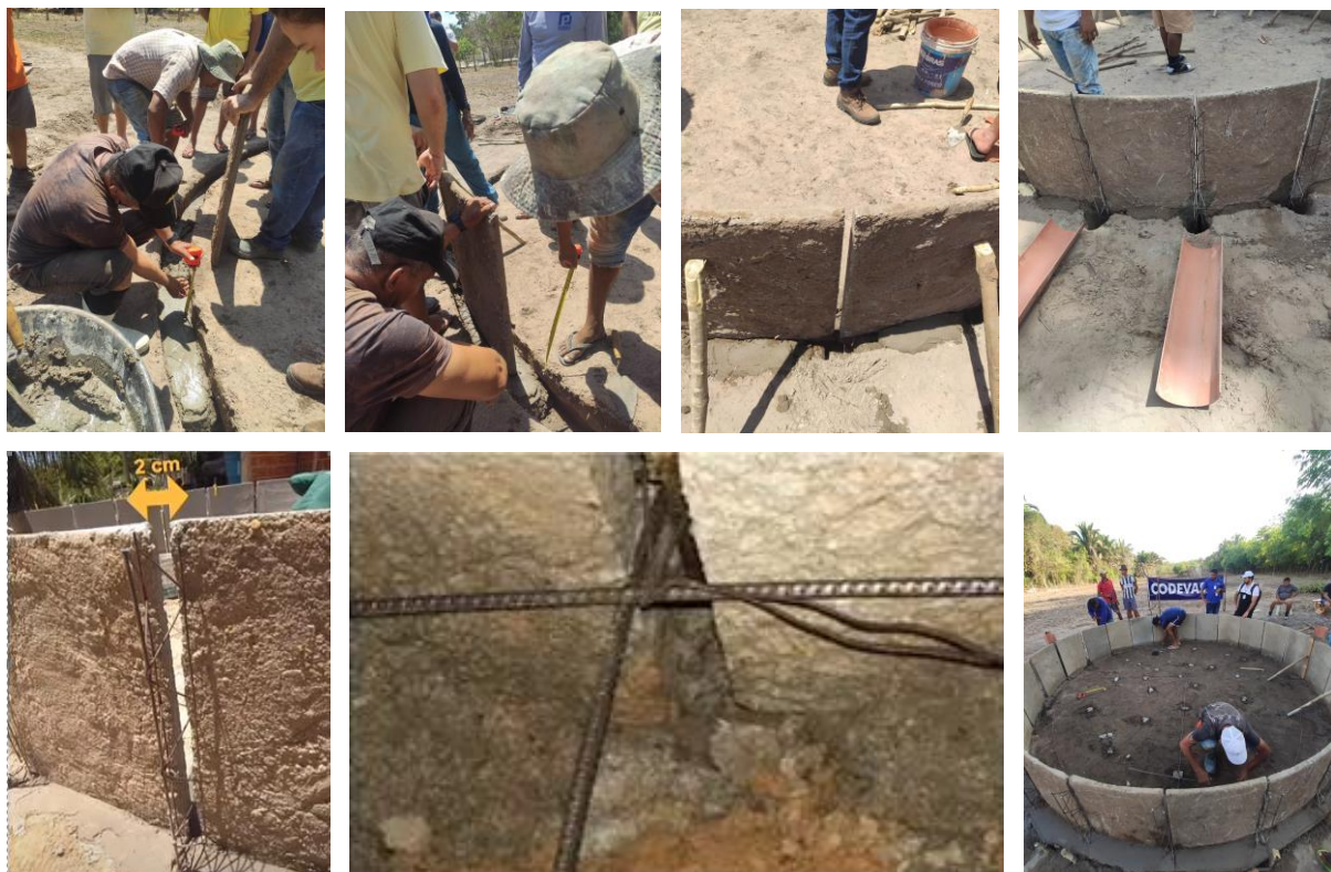
Figura 3: Demonstração da distância entre placas, utilização da treliça e arame recozido Fonte: CODEVASF
