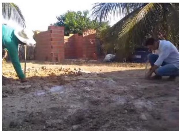
Figura 1: Demonstração da marcação do perímetro do reservatório.
