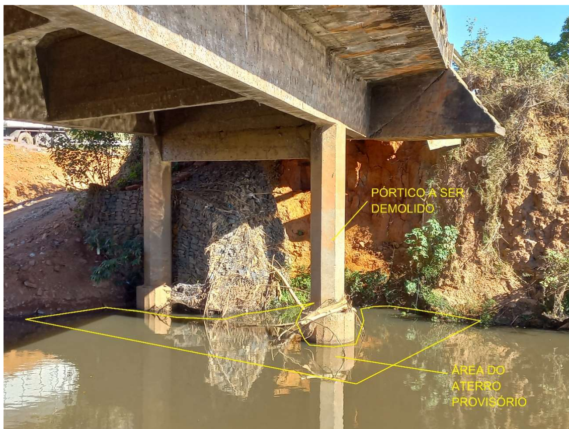
Imagem n.º 14 – local de execução do aterro provisório de acesso para execução do estaqueamento.
