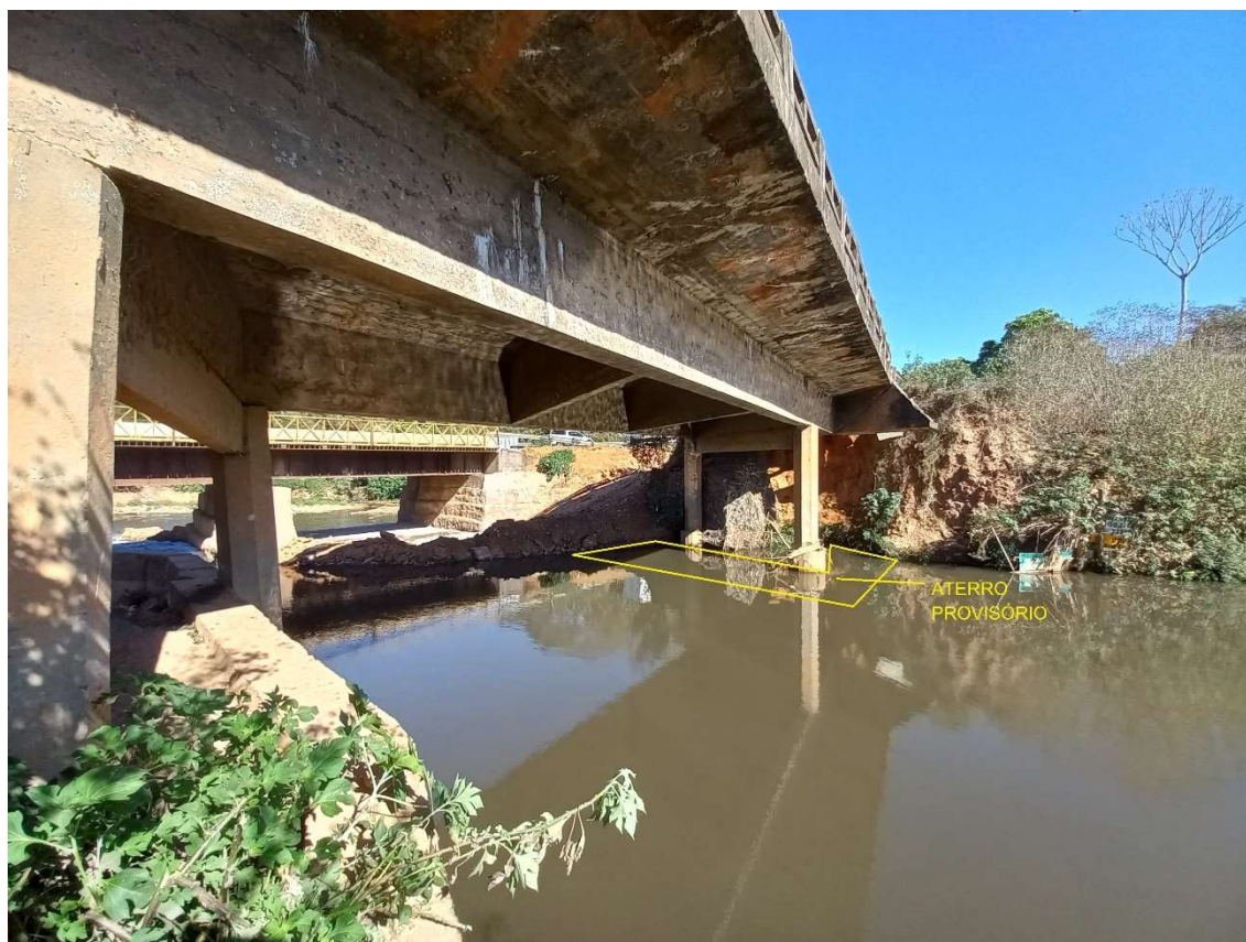
Imagem n.º 13 – local de execução do aterro provisório de acesso para execução do estaqueamento.
