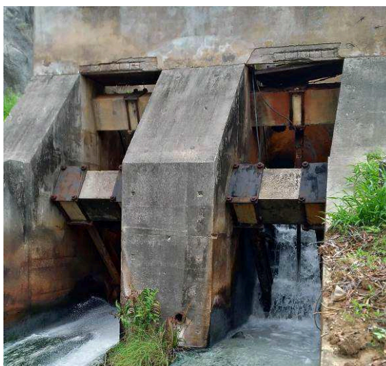
Figura 3 – Comportas segmento da descarga de fundo.
