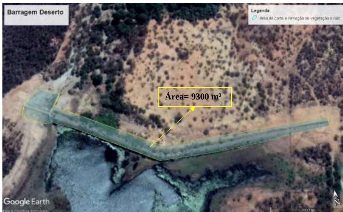
Figura 1 – Vista superior da Barragem Deserto com a crista, talude de montante, talude de jusante, área a jusante e parte do canal de aproximação/restituição demarcada.
