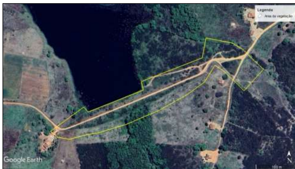
Figura 01: Vista superior da Barragem Camará com indicação da área a ser realizada a limpeza de vegetação.
