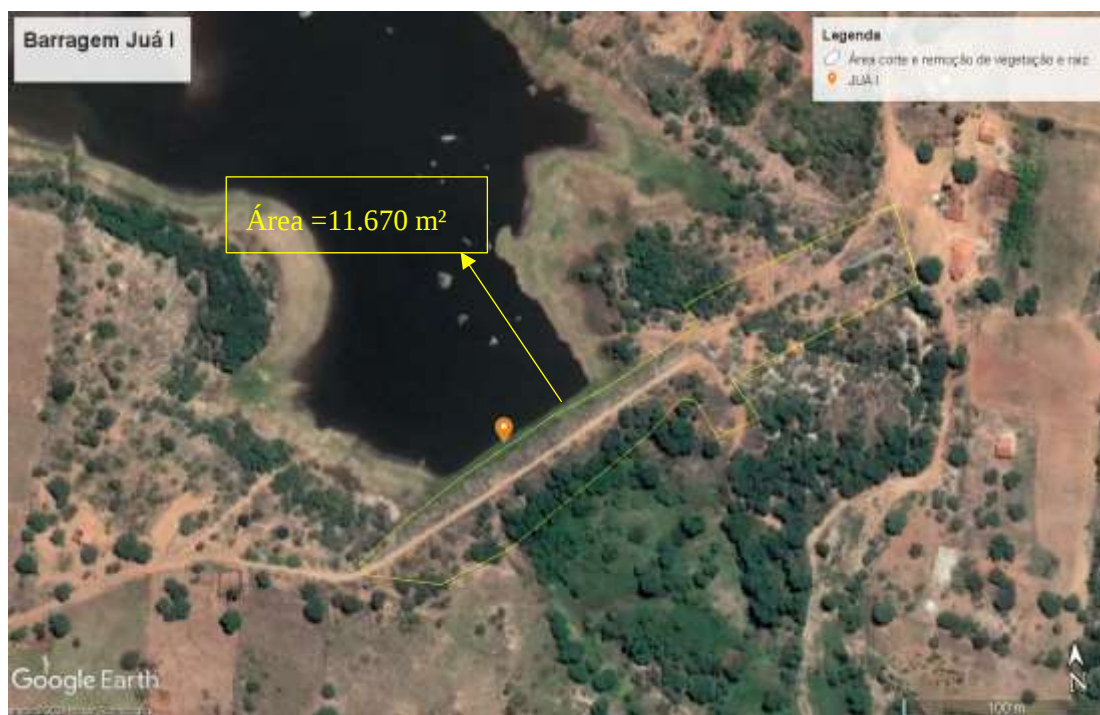
Figura 1 - Vista superior da Barragem Juá I com o talude de montante, área da crista, talude de jusante, área a jusante e parte do canal de aproximação/restituição demarcada.
