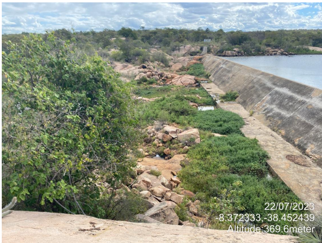
Figura 1 - Vista da Barragem Água Fria da área a ser realizada a limpeza de vegetação: barragem e estruturas auxiliares.
