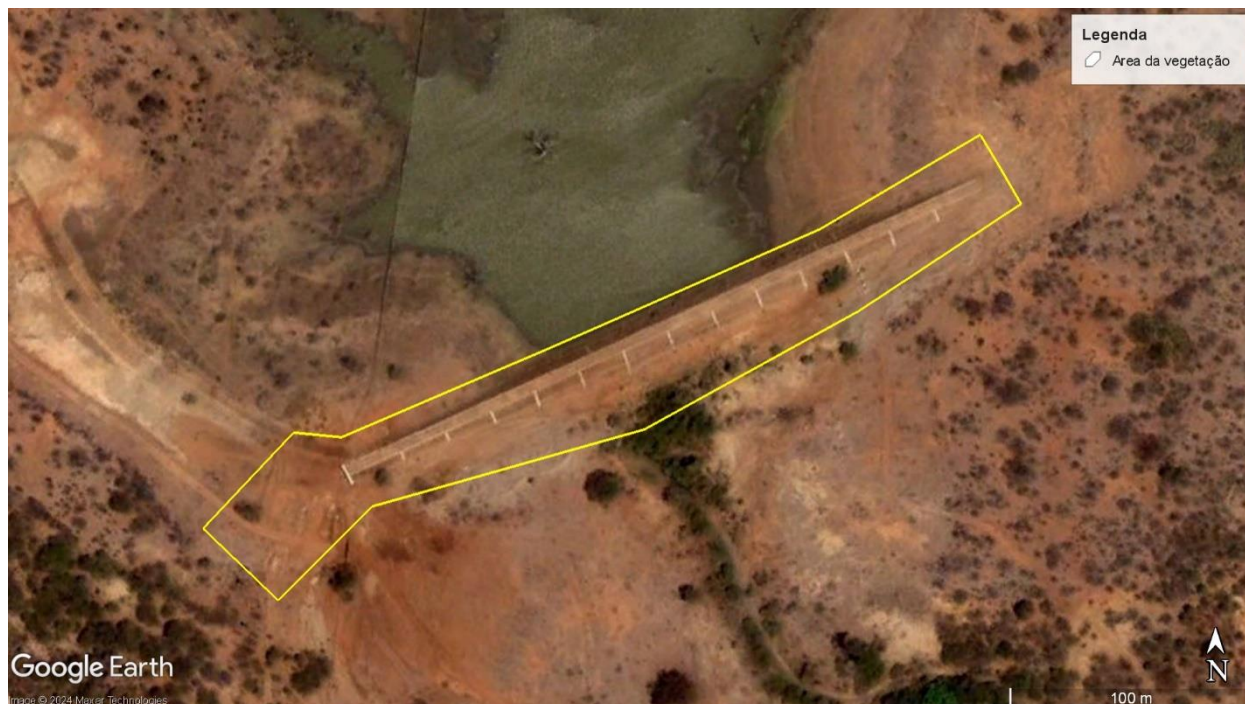
Figura 1 – Vista superior da Barragem Angico com indicação da área a ser realizada limpeza de vegetação: talude de montante, crista, talude de jusante, região a jusante e parte do canal de aproximação/restituição demarcada.
