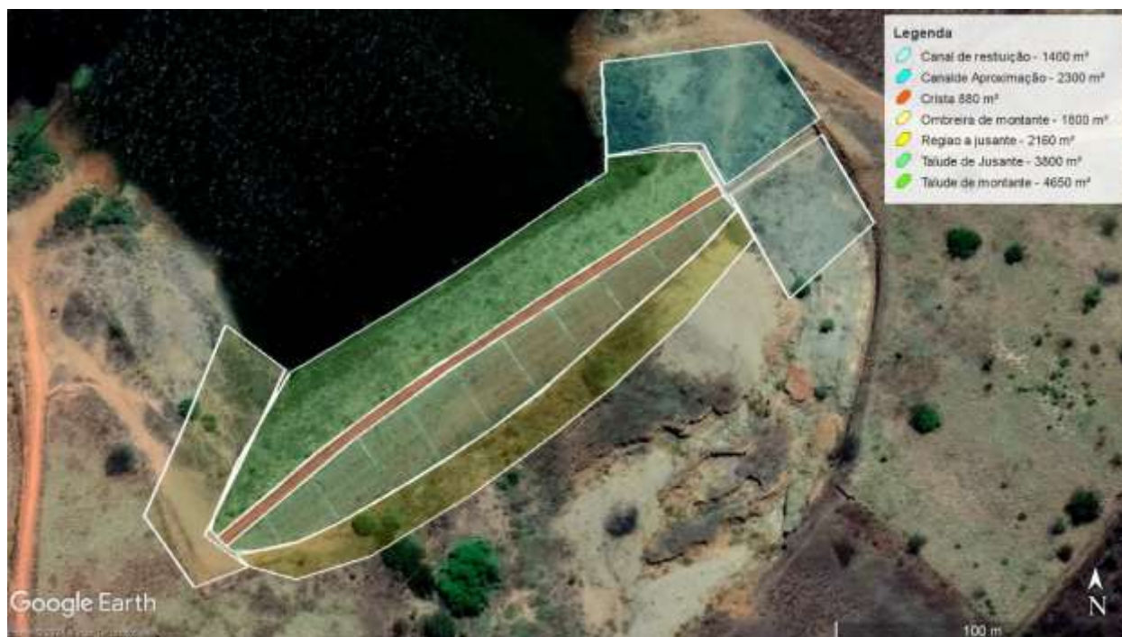
Figura 1 - Vista superior da Barragem Tranqueira com indicação da área a ser realizada limpeza de vegetação: talude de montante, crista, talude de jusante, ombreira, região a jusante e parte do canal de aproximação/restituição demarcada.
