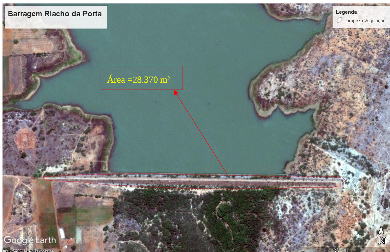
Figura 1 – Vista superior da Barragem Riacho da Porta com o talude de montante, área da crista, talude de jusante e área a jusante demarcada.
