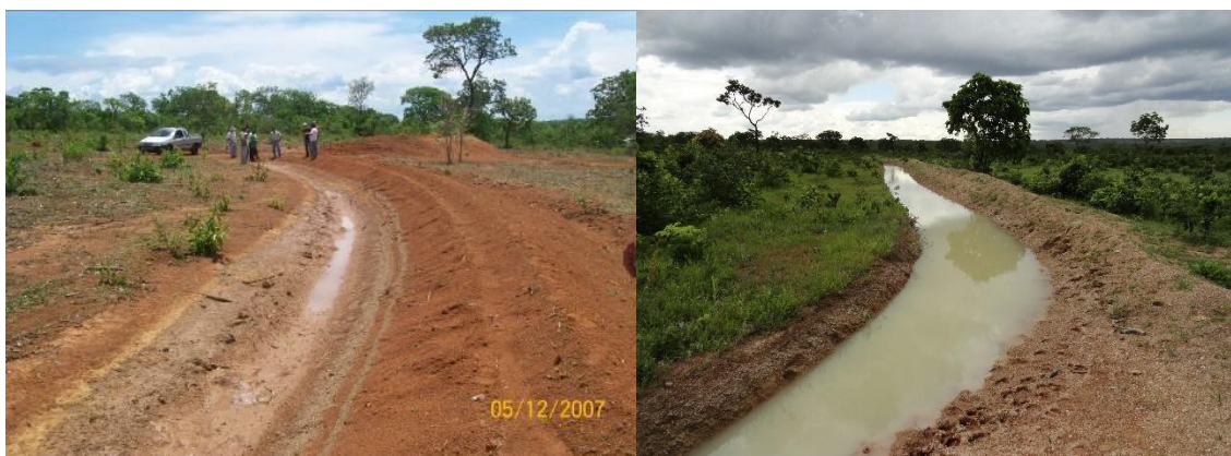
Figura 3: terraços demonstrando a função de acúmulo e infiltração de água devido à construção em nível. Fonte: Jordão (2020).
